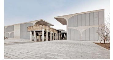
Entrée du Long Museum West Bund, à Shanghai. Photo : Long Museum West Bund.
